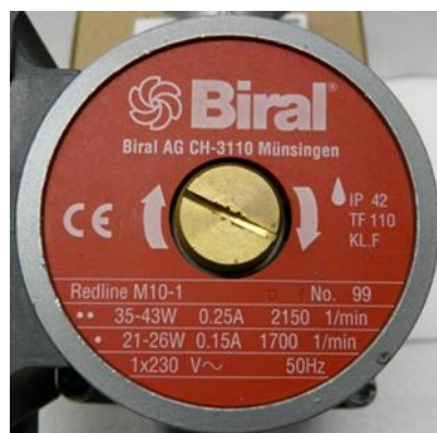
Abbildung 2: Typenschild Pumpe, Quelle: Biral Redline M10-1
