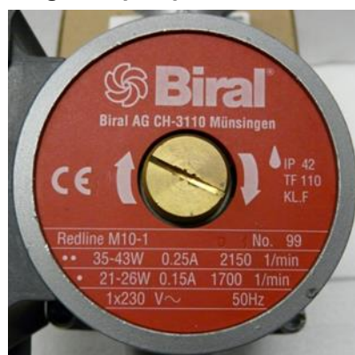
Figura 2: targhetta pompa. Fonte: Biral Redline M10-1
