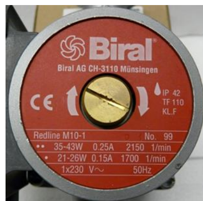
Abbildung 2: Typenschild Pumpe, Quelle: Biral Redline M10-1
