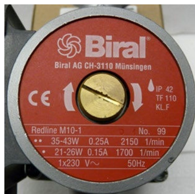
Figura 2: targhetta pompa. Fonte: Biral Redline M10-1
